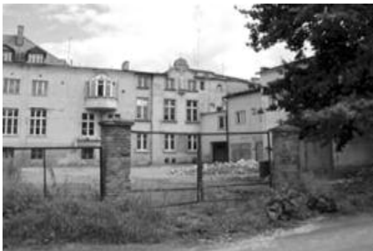
Rys. 11. Stan obiektów przed rozpoczęciem prac Źródło: http://www.miastochojnice.pl/foto/3482.jpg
