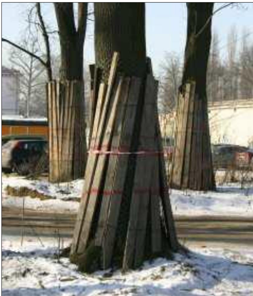
Fot. 15 Przykładowy sposób ochrony pnia drzewa przed uszkodzeniami mechanicznymi
