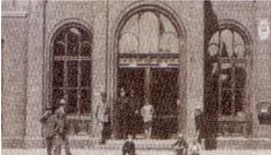
fot.10 Okna i drzwi na elewacji frontowej, nowa stolarka powinna odtwarzać historyczne podziały i profile.
