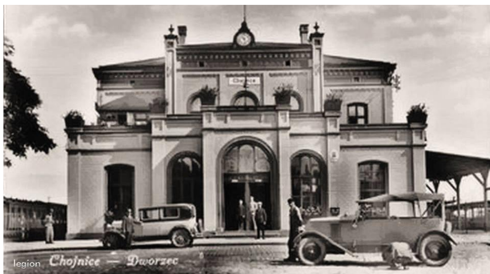
Fot.8 Budynek dworca – lata 30-te elewacje budynku pokryte jasną farbą, opaski okienne i gzymsy kolorem ciemniejszym, stolarka ciemna; za fot opolska..
