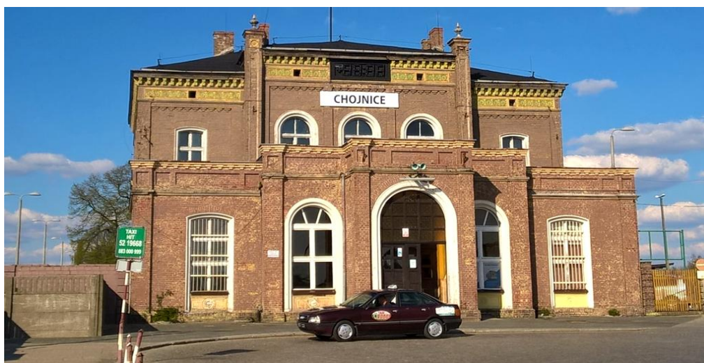
Fot.5 Budynek dworca kolejowego w Chojnicach, stan obecny, elewacje pokryte czerwoną farbą, detal żółtą, opaski wokół okien biała, stolarka okienna biała
