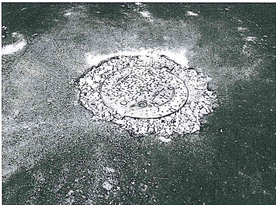
Zdjęcie nr 1 – zabezpieczenie powierzchni wokół studzienki kruszywem
