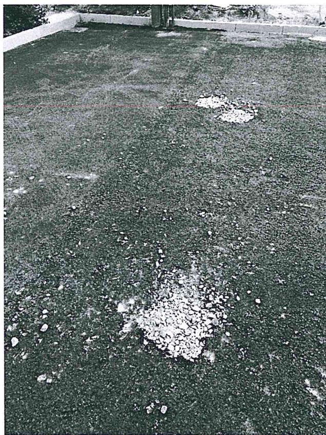
Zdjęcie nr 2 – zabezpieczone kruszywem przyłącza
