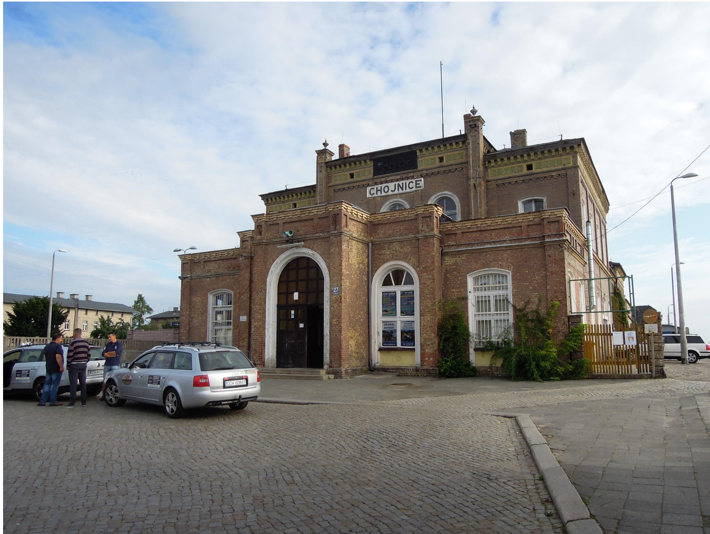
PRZEBUDOWA, REMONT I KONSERWACJA DWORCA KOLEJOWEGO ORAZ ZAGOSPODAROWANIE TERENU
