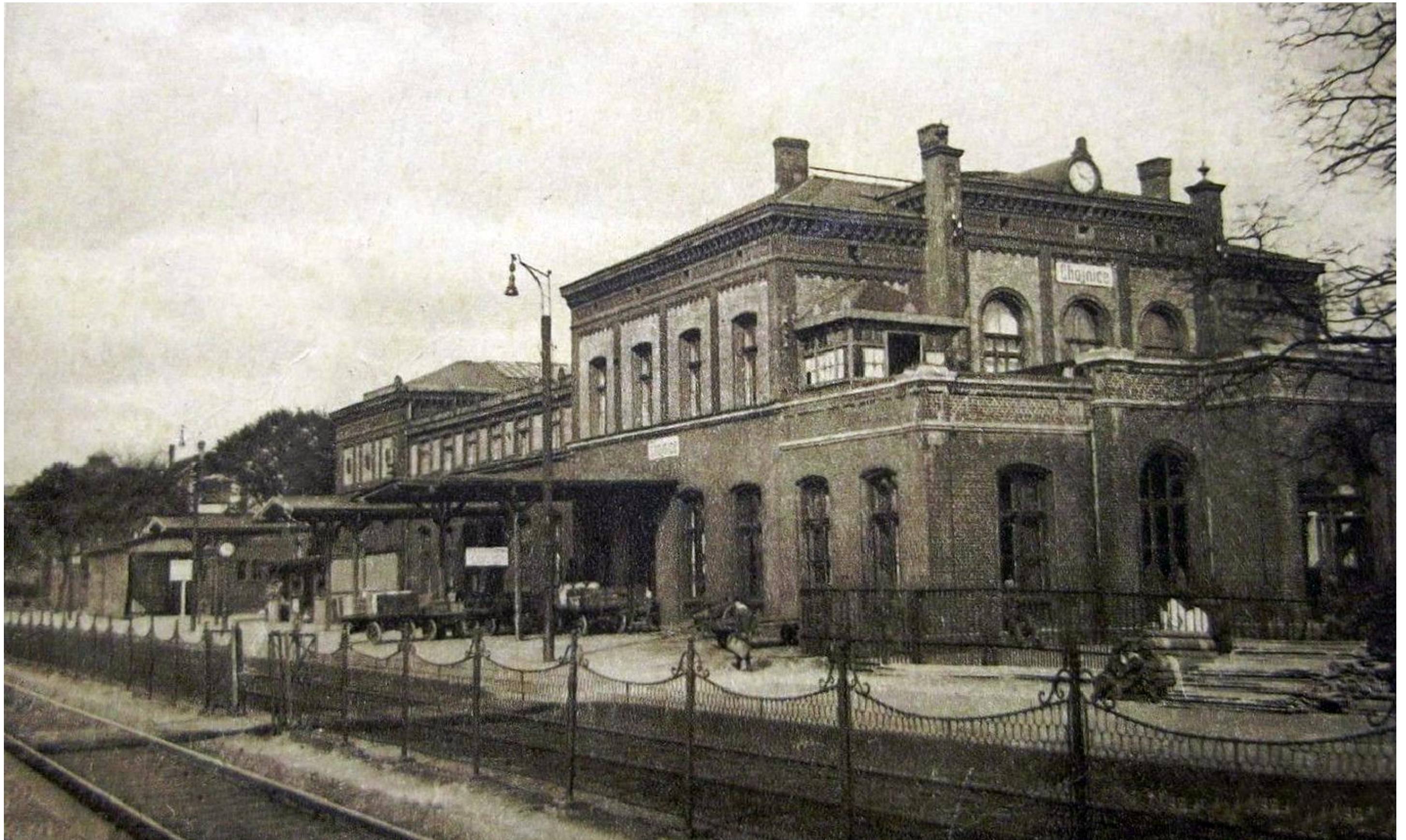
PRZEBUDOWA, REMONT I KONSERWACJA DWORCA KOLEJOWEGO ORAZ ZAGOSPODAROWANIE TERENU
