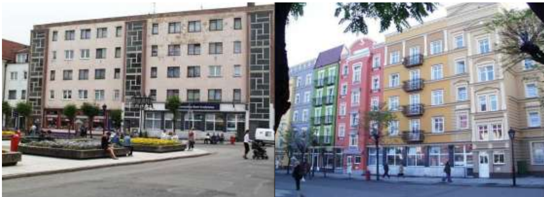
Fot. Przykład remontu i przebudowy (zdjęcie przed i po remoncie) fasady budynku wielorodzinnego podnoszącej jakość przestrzeni publicznej podobszaru Śródmieście źródło: miastochojnice.pl
