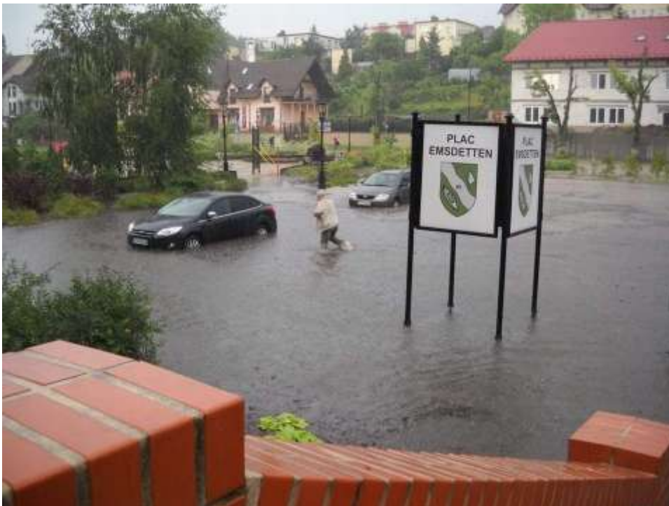
Fot. Skutki nieuregulowanego systemu odprowadzania wód opadowych w Chojnicach – Plac Emsdetten na podobszarze Śródmieście
