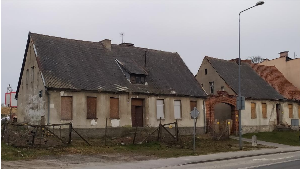
Fot. B.Bluma – budynki przy ul. Strzeleckiej 11 i 13 – stan obecny (27.03.2020)
