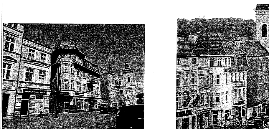
Elewacja zabytku ul. Gimnazjalna 7.
