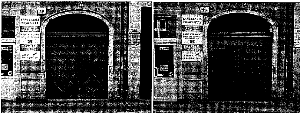
ul. Młyńska 19 – budynek z 1886r. wymiana stolarki drzwiowej
