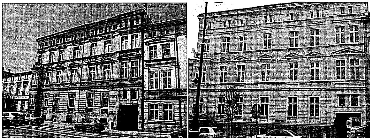
Plac Jagielloński 7 - budynek z 1903r.
