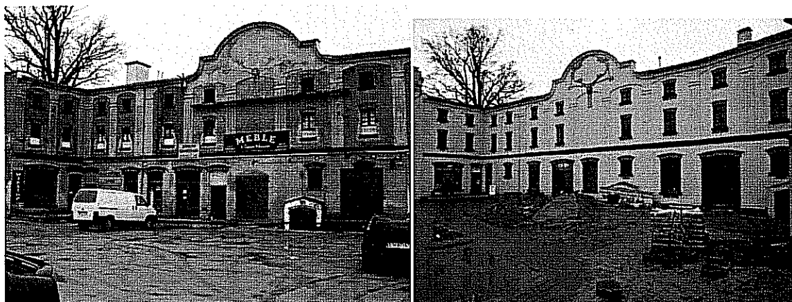
Elewacja frontowa magazynu z secesyjną ornamentyką oraz detalem architektonicznym.
